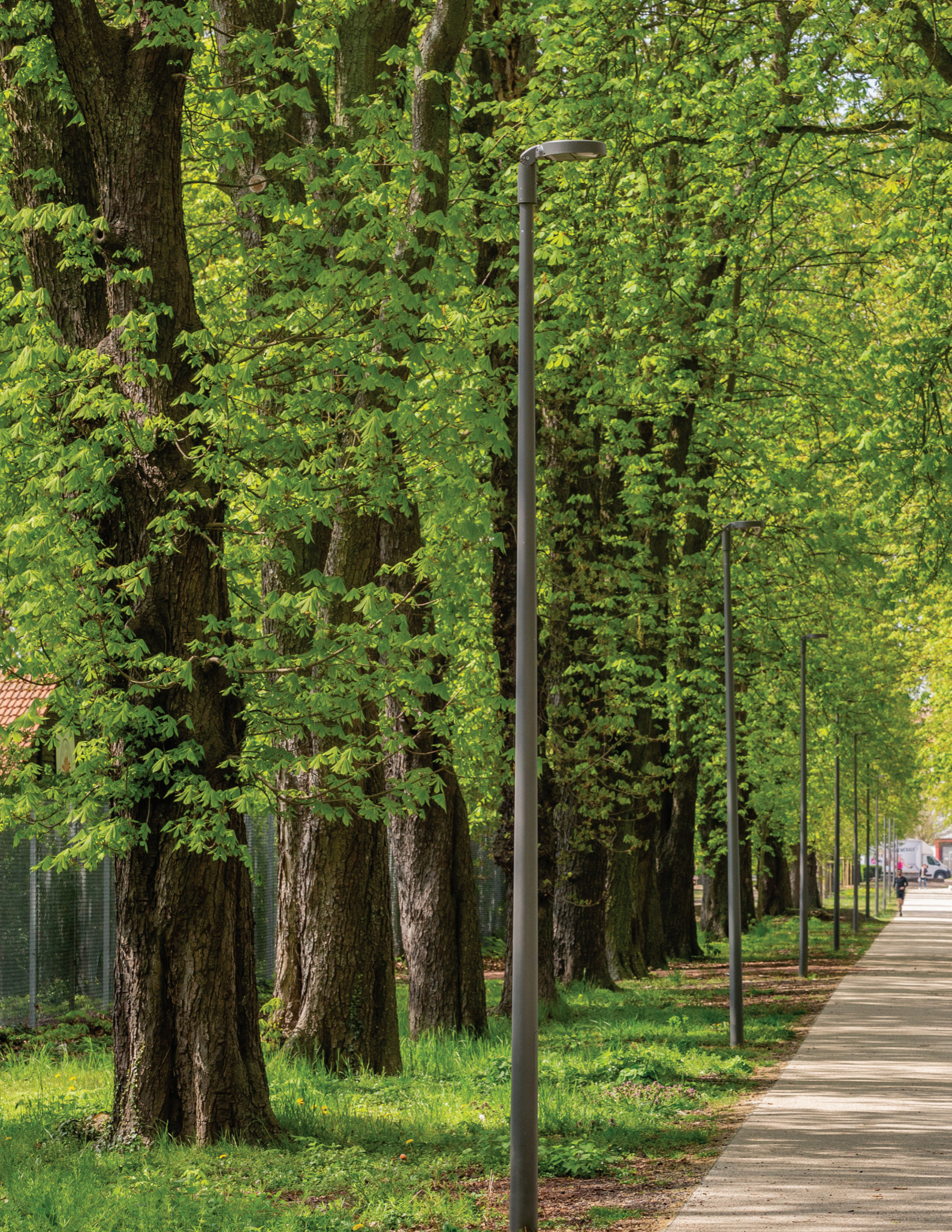
Piste cyclable du boulevard Henri II, Metz (France). Maître d'ouvrage : City of Metz. Maître d'œuvre : service de l'éclairage public de Metz Metropole. Installateur : SOBECA © FLUX
