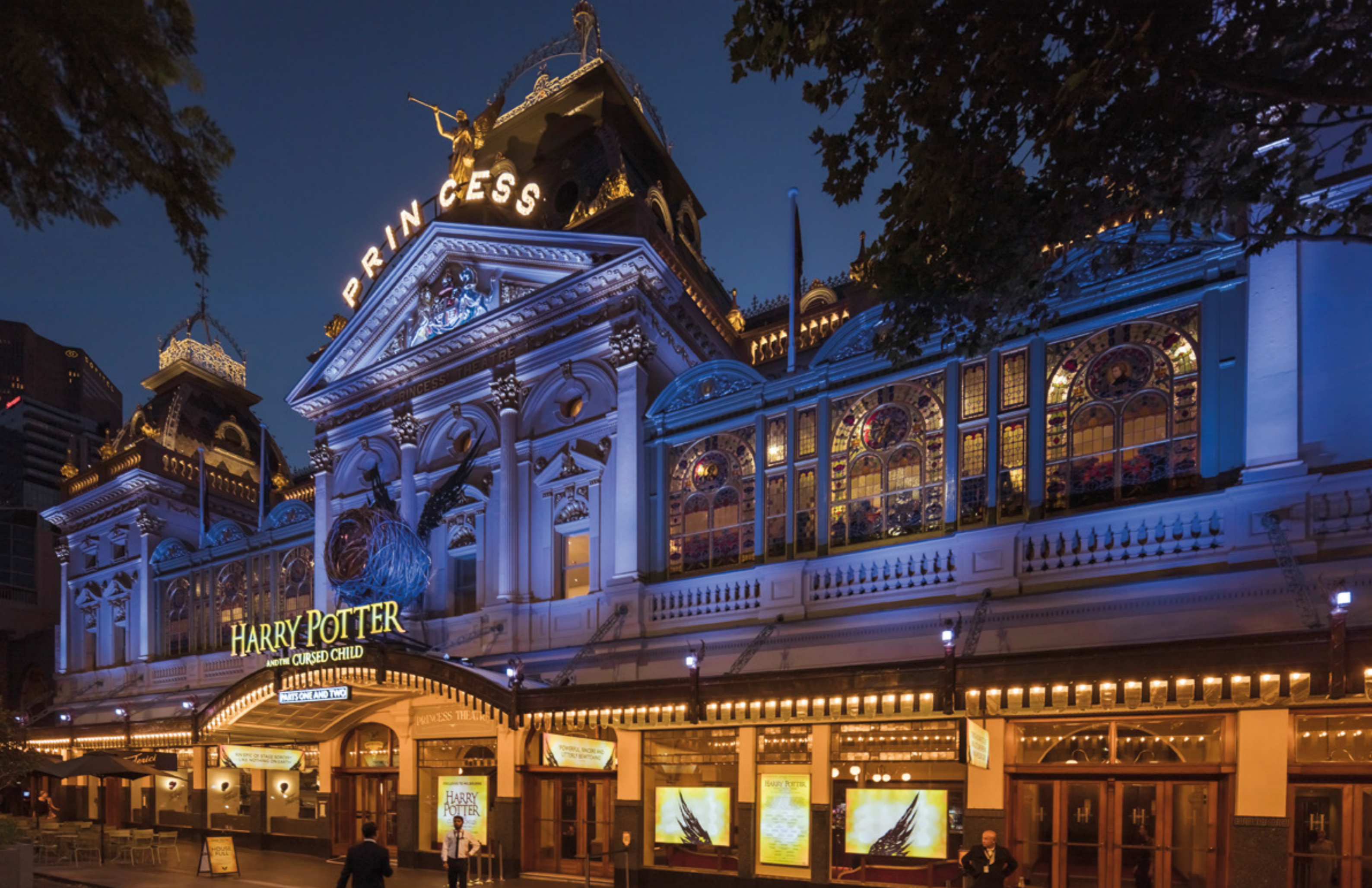
The Princess Theatre, Melbourne (Australie). Maître d'ouvrage : Marriner Group. Architecte : Lovell Chen Architects. Installateur : Marriner Group. © Jackie Chan
